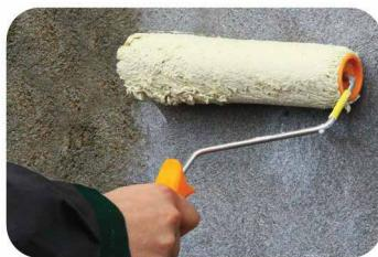
**ЭТАП 1.** Основание под нанесение армирующей штукатурной смеси должно быть прочным, сухим и чистым. Обработать поверхность газобетонного блока грунтом ОСНОВИТ УНКОНТ ЛЮКС LP51 А. При необходимости нанести грунт в несколько слоев.
