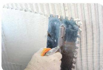
**ЭТАП 3.** Армирующая стеклосетка (с нахлестом не менее 10 см) укладывается на свеженанесенный штукатурный слой, «втапливается» в него и заглаживается таким образом, чтобы сетка находилась в середине базового слоя.
