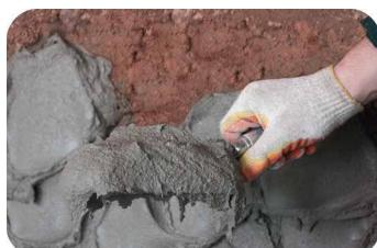
**ЭТАП 2.** Наносим на основание раствор цементной штукатурки, обладающей высокой стойкостью к механическим и атмосферным воздействиям.
