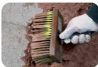
**ЭТАП 1.** Предварительно смочив поверхность, наносим штукатурный обрызг резким махом руки макловицей. Не разравниваем. Удаляем только чрезмерно выступающие участки материала. При возможности набрызг может выполняться механизированным способом.
