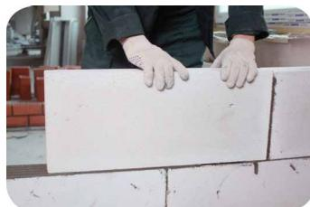
**ЭТАП 2.** Укладываем блок, прижимаем с усилием, удаляем излишки раствора.
