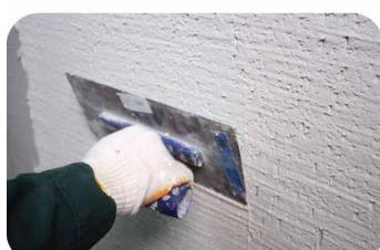
**ЭТАП 4.** Наносим декоративную штукатурку. Равномерно распределяем ее по поверхности.
