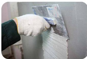
**ЭТАП 2.** С помощью зубчатого шпателя или гладилки штукатурно-клеевой раствор наносится тонким слоем на поверхность газобетона и равномерно распределяется.
