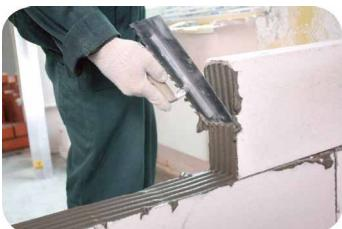
**ЭТАП 1.** Наносим кельмой раствор на горизонтальную поверхность блоков предыдущего ряда и вертикальную поверхность бокового блока.
