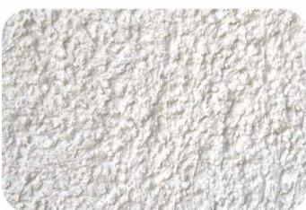
**ЭТАП 4.** Придаём желаемую фактуру поверхности. Для получения качественной поверхности желательно как можно чаще очищать рабочую поверхность инструмента от раствора.
